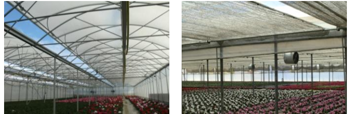
Ventilación cenital y lateral, combinada con el uso de ventiladores suplementarios para crear el máximo de movimiento de aire posible.
