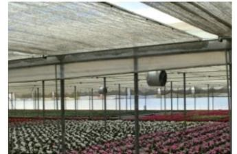
Ventilazione zenitale e laterale, unita all'utilizzo di ventilatori supplementari per creare il più possibile un movimento d'aria
