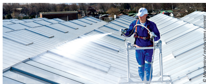
Aplicación de la pintura con pistola
