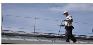
Aplicación del detergente especial para la eliminación del revestimiento
