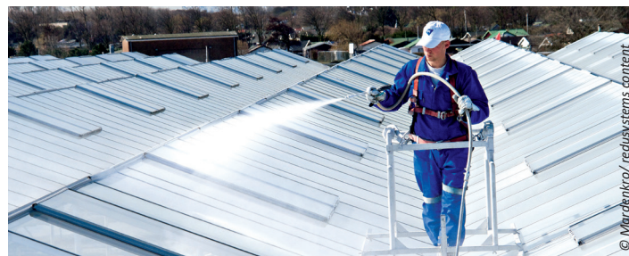
Aanbrengen van de verf met verfpistool
