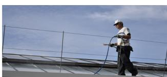
**Aplicação do detergente especial para a eliminação do revestimento**
